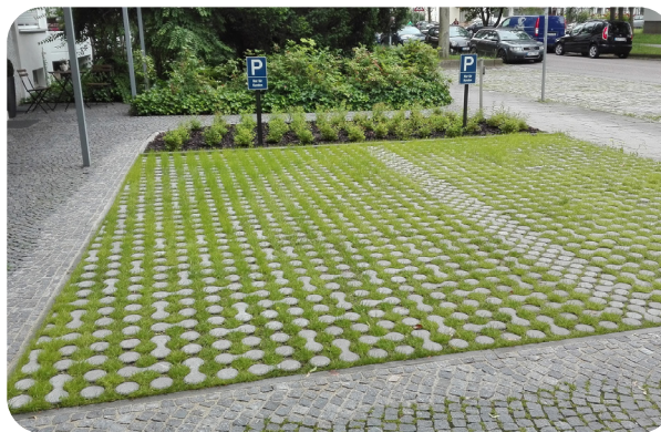
Abbildung 6.2.17: Referenz Parkplatzbelag (Godelmann, 2023)
